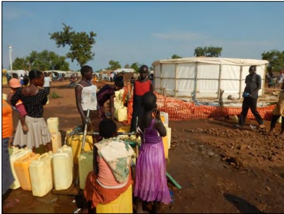
Yumbe 県難民居住区内にある給水施設 2017年7月28日(金)
