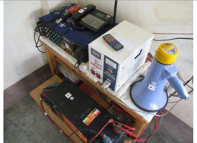
Hlwa Zar Village Tract に導入された CDMA 設置電話とハンドスピーカー
