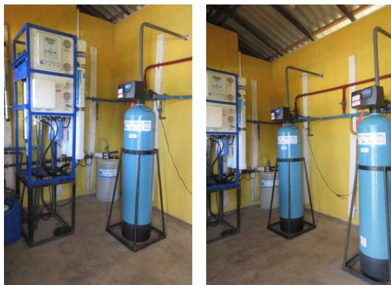
写真 9 米国製の RO 膜浄水機
