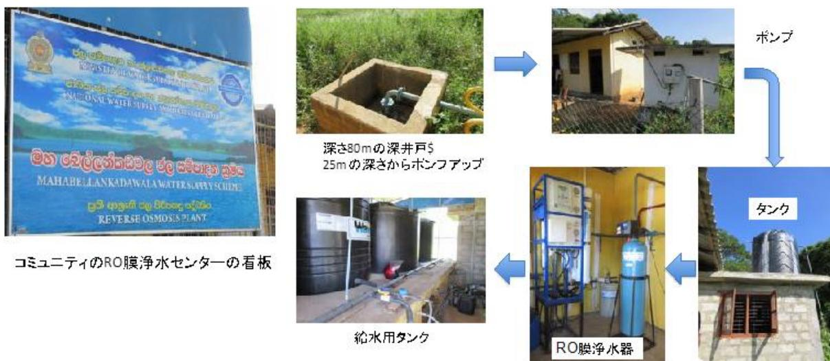
図 27 コミュニティーRO 膜浄水センターの浄水システム
