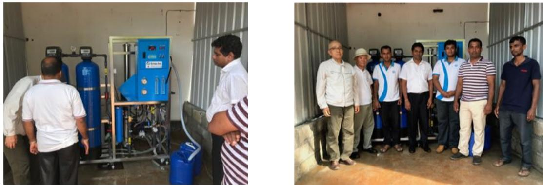
写真 25 CKDu プロジェクトオフィスに設置した RO 膜浄水機
