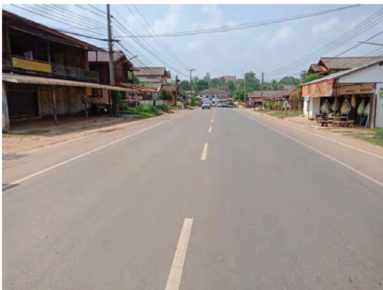
CFA+AC Pavement Section (NR-13N)
