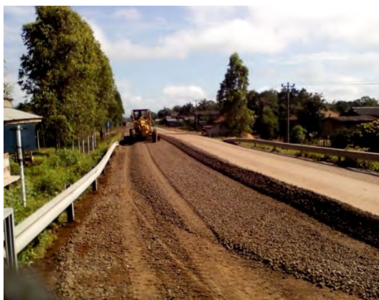
路盤材敷き均し
