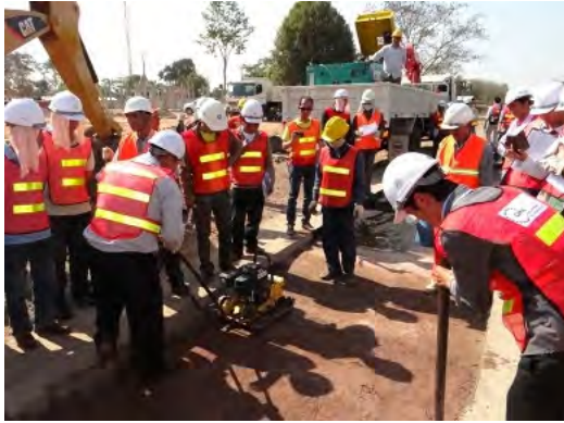
補修作業実地（局部置換工）
