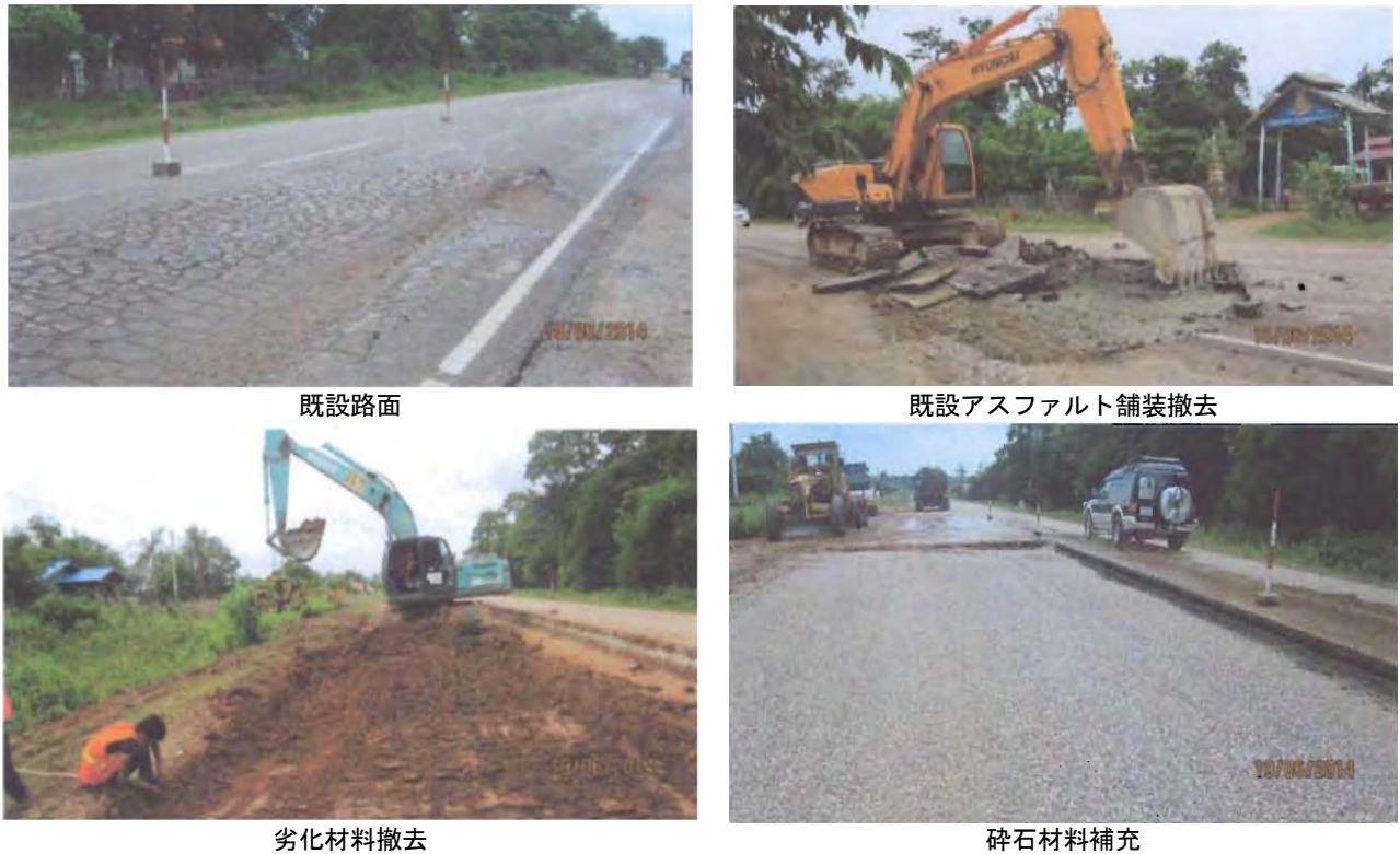
図 2.4.22 緊急補修工事作業
