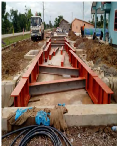
プラットフォーム用鋼材設置
