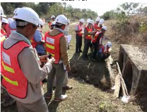
日常点検実地 (横断管)
