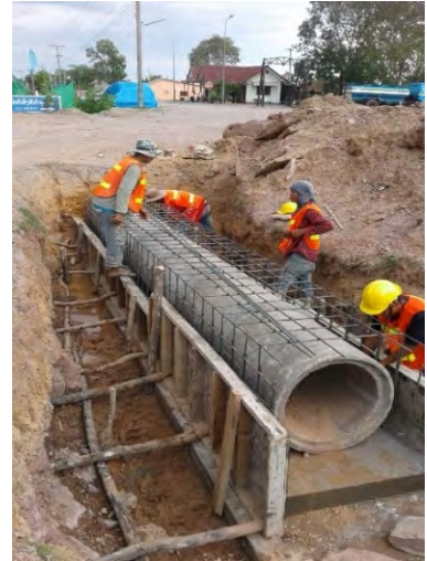
パイプカルバート敷設
