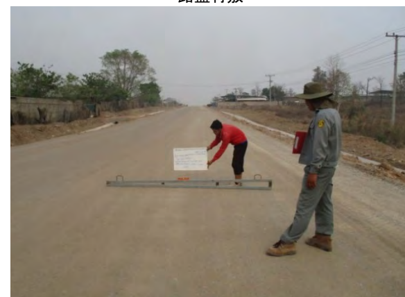
路盤補修完了
