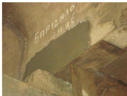
主桁断面補修（補修後）
