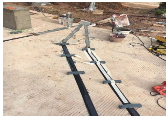
車両感知用センサー設置
