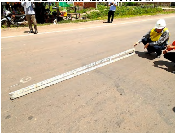
第3工区 完成検査 (2016年9月26日)
