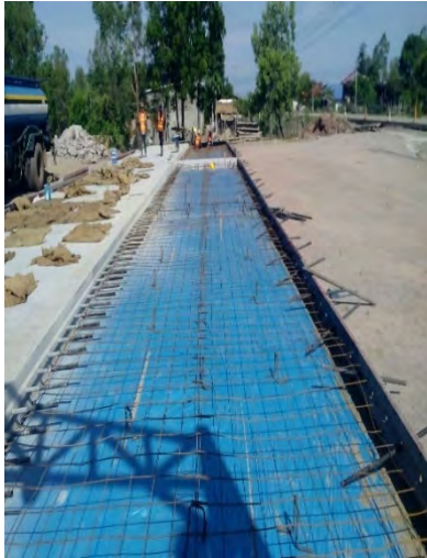
コンクリート舗装ワイヤメッシュ敷設
