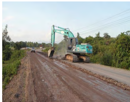
既設アスファルト舗装撤去
