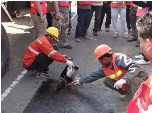
補修作業実地（クラックシール）
