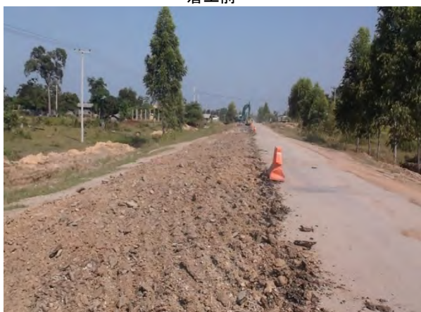
劣化材料撤去
