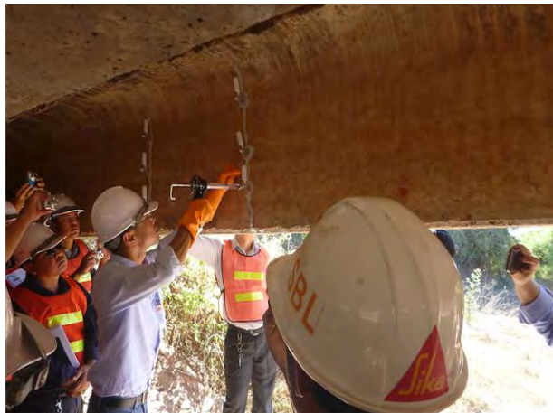
クラック注入デモンストレーション
