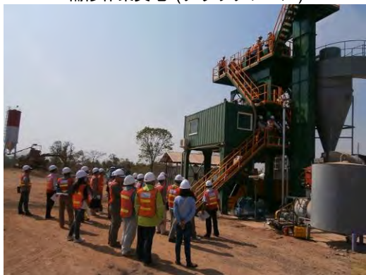
アスファルトプラント
