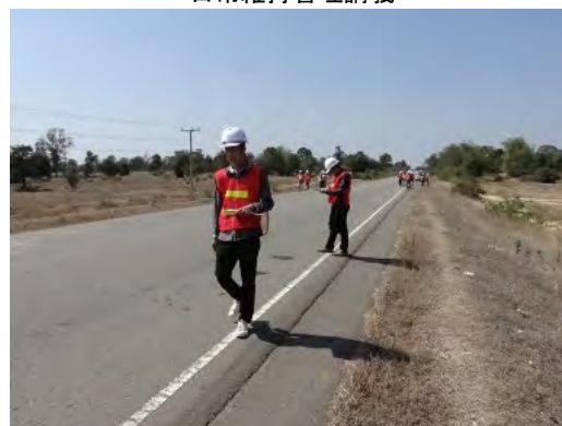
詳細点検実地 (舗装)
