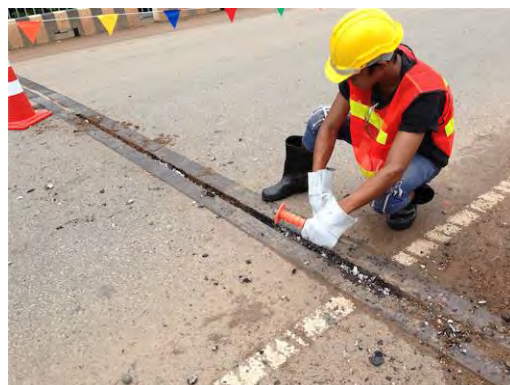
エクspansionジョイントの補修
