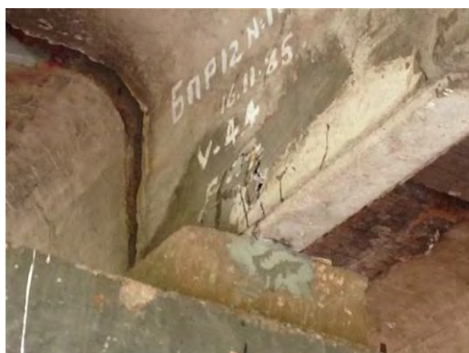
主桁断面補修（補修前）
