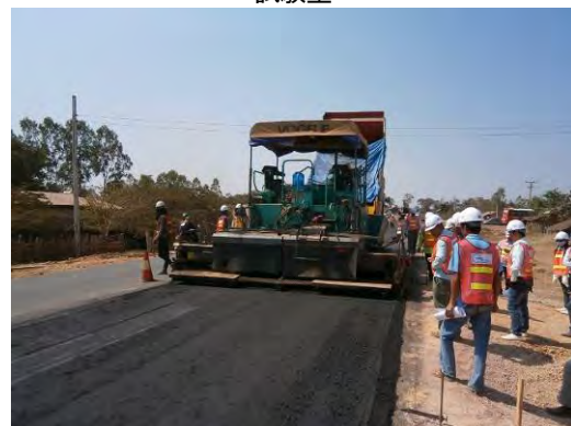
舗装工事（表層）
