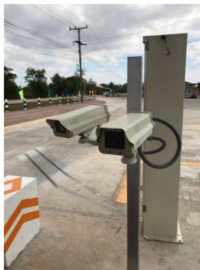
自動ナンバープレート・車両タイプ読み取り用機器
