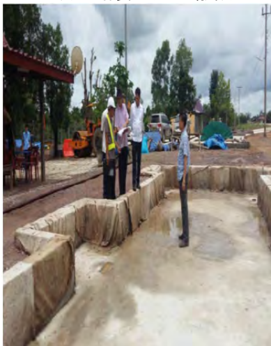
計量器基礎コンクリート養生
