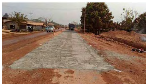
既設道路にセメント散布
