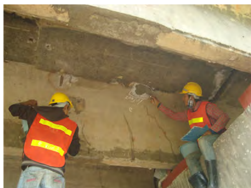
下床板の補修
