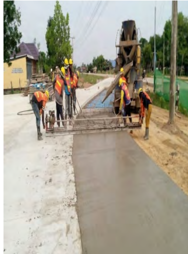
コンクリート舗装表面仕上げ
