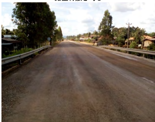
路盤補修完了
