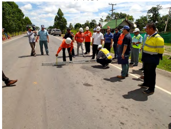
第3工区 完成検査 (2016年9月26日)
