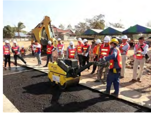
補修作業実地（局部置換工）
