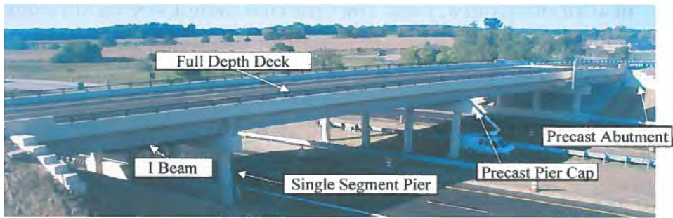
図1：Parkview Bridge全景
