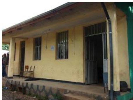
リベン・チュカラ郡農業・自然資源事務所内の敷地に建設された建物（会議室と事務所が設けられている）
