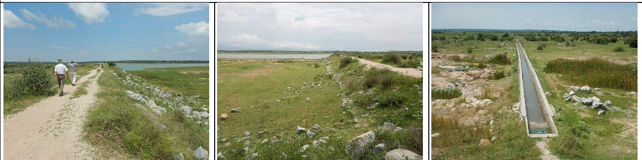
03. Mahiga ダム (ため池) 灌漑スキーム、Kwimba 県、Mwanza ゾーン
