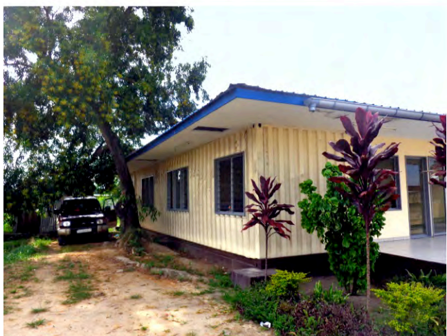
写真 -14：事業サイト内の EIZ 供与の事務所 相手国側負担により移設予定。
