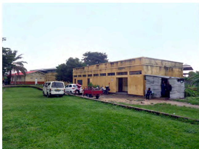
写真 -15：事業サイト内の保健棟 相手国側負担により撤去予定。
