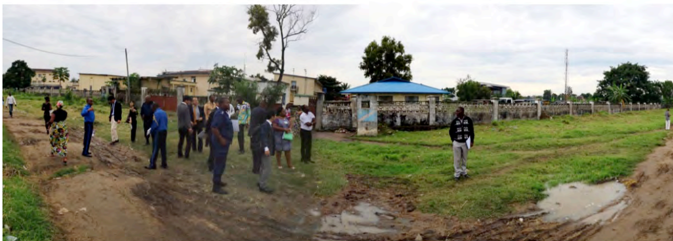
写真 -16：事業サイト北側道路緑地帯（2017年2月撮影） 工事中は仮設エリアとして使用予定。道路はまだ舗装されていない。正面奥が事業サイト。
