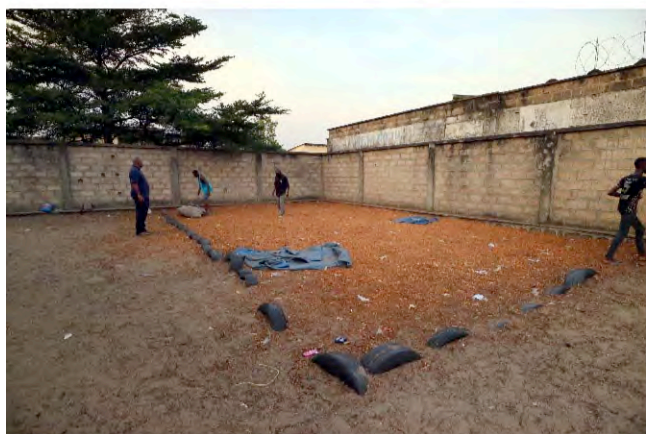
写真 -3：屋外柔道場の設営-1 タイヤで仕切られたエリアに厚み 30cm 程度 のおが屑が敷きつめられている。おが屑は約半年 に1回交換する。
