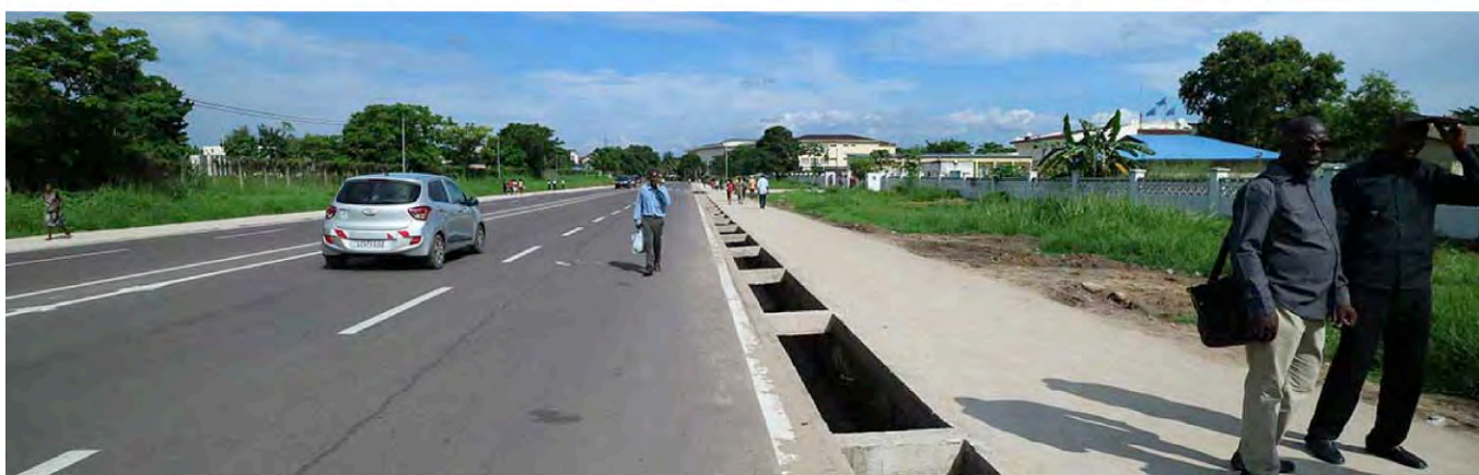
写真-17：事業サイト北側道路（2017年8月撮影）
