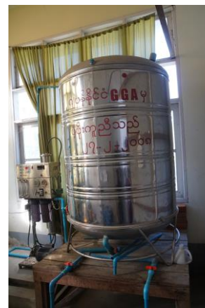
UDMM 内：電圧安定器（左）と浄水器（右）
