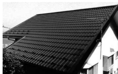
図9 マックス瓦の施工後の屋根
