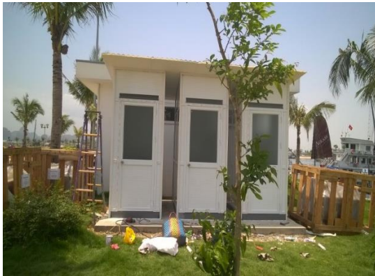
バイオトイレ設置作業 (Tuan Chau 港)
