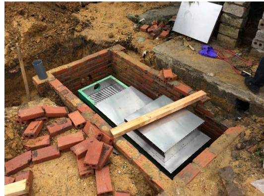
新浄化装置設置作業 (一般家庭)
