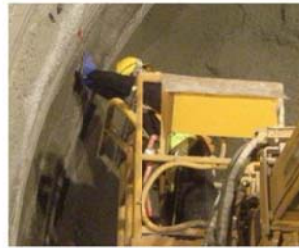
Colocando el perno de roca
