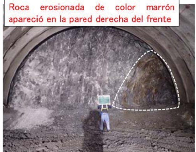
【 Condición geológica después de la voladura 】
