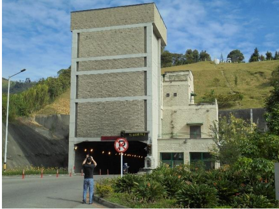
写真-2.3 トンネル入口
