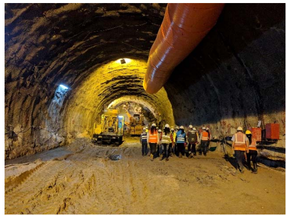
写真8 トンネル内部
