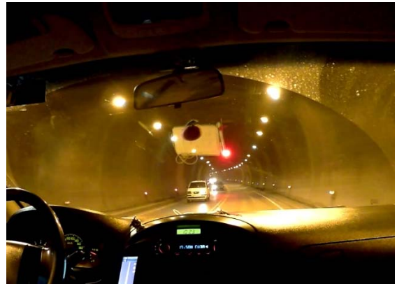
写真2 ブエナビスタトンネル
