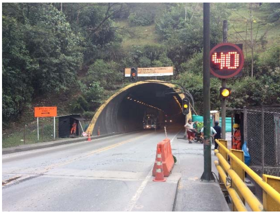
写真3 7号トンネル (KM77+846)
