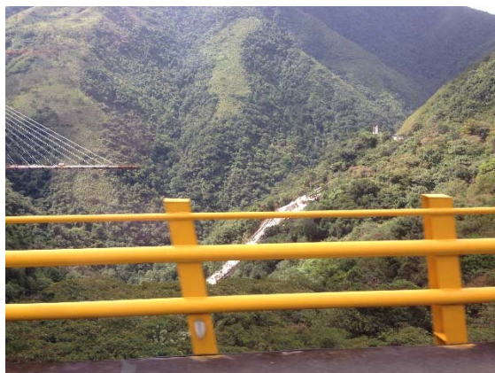
写真5 1月に崩落した斜張橋
