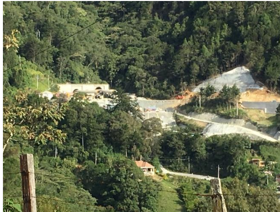
写真- 4.1 坑口と周辺の様子
