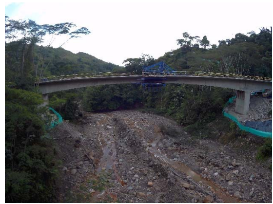
写真4 7号トンネル近辺に建設中のPC橋
