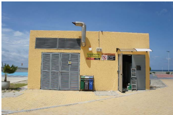
写真5 非常用電源室(250kV)
