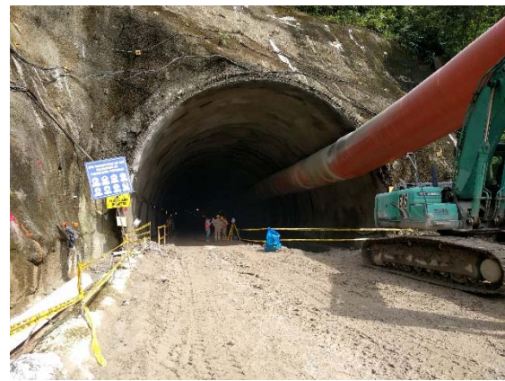
写真7 トンネル坑口
