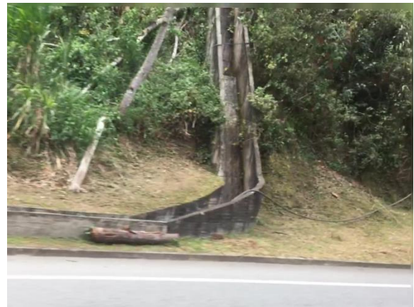
写真-3.2 沢水を引くホース
