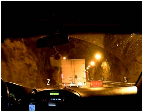
写真1 覆エコンクリートのないトンネル
