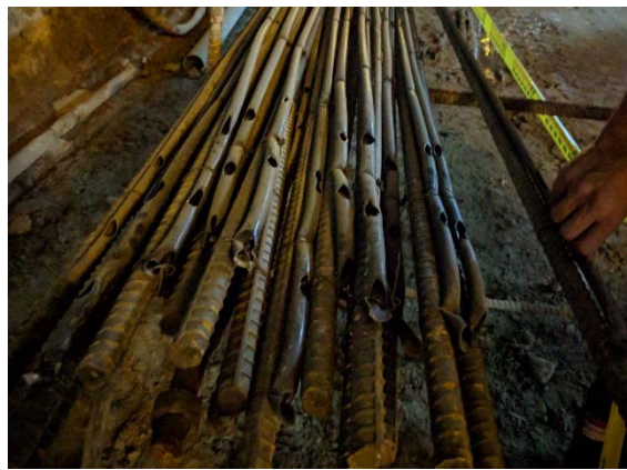
写真10 セメント注入筒つきロックボルト
