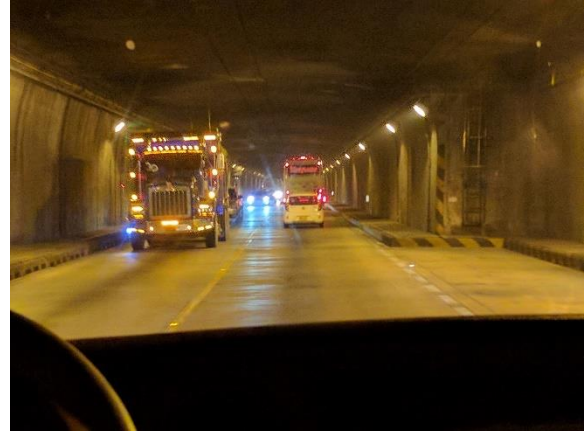
写真-2.4 トンネル内部
