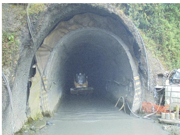
写真-1.1 パイロットトンネル坑口
