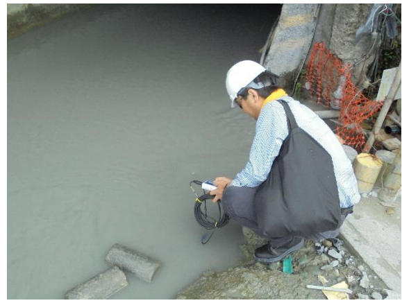
写真-1.4 パイロットトンネル排水の検査
