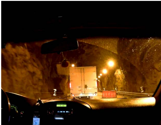
写真1 覆エコンクリートのないトンネル
