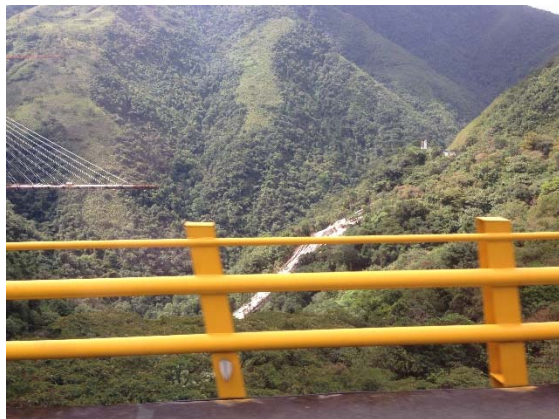
写真5 1月に崩落した斜張橋
