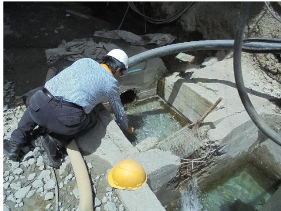
写真-1.6 メイントンネル排水の検査
