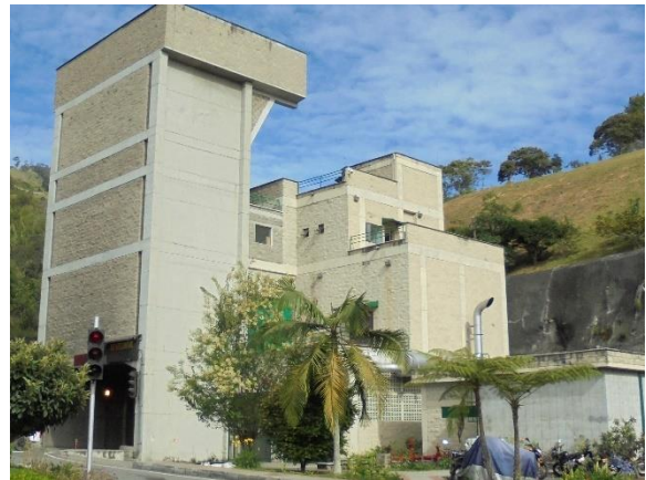
写真-2.2 トンネル入口側面
