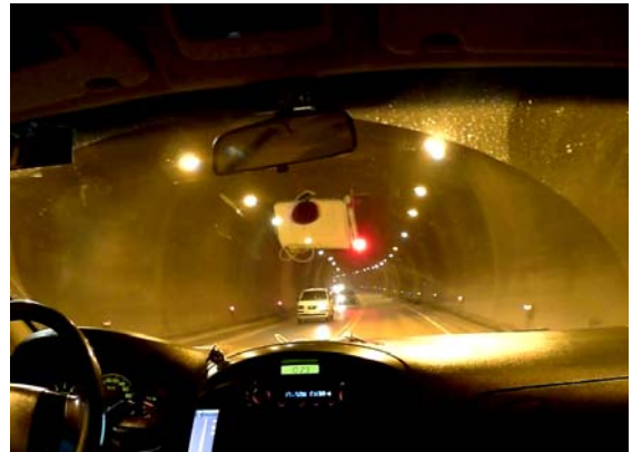
写真2 ブエナビスタトンネル
