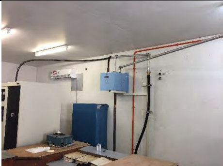
PREP プロジェクトで納入されたスイッチオーバーユニット(上部)とダミーロード(下部)
