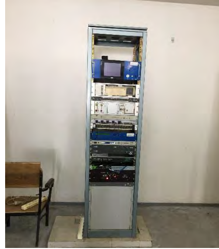
既存音声信号入力用ラック。PREP プロジェクトで納入された機材が一部追加設置されている。
