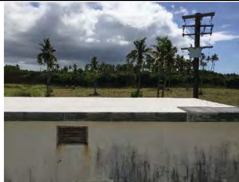
屋根防水再塗装跡
