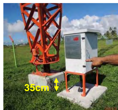
既設中波アンテナシステム基部
