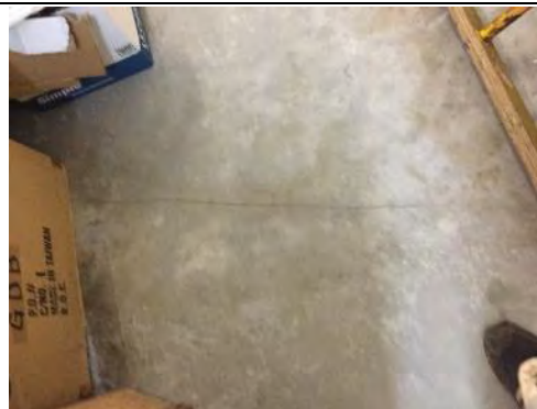
スラブ上にクラック有り
