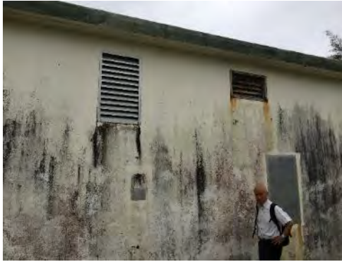
外壁に汚れ多数
