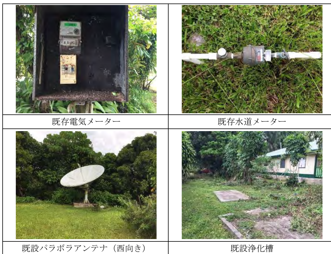
写真 2-1-4 本局サイト外構設置物
