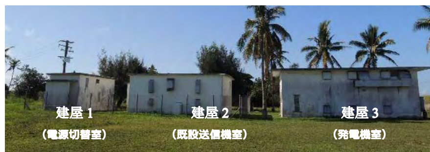
写真 2-1-5 ポプア送信所既設建屋
