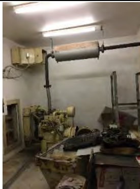
未使用発電機
