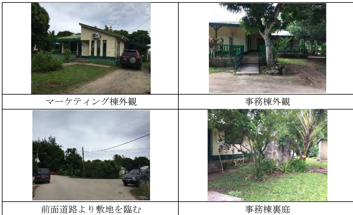
写真 2-1-3 本局サイト外観
