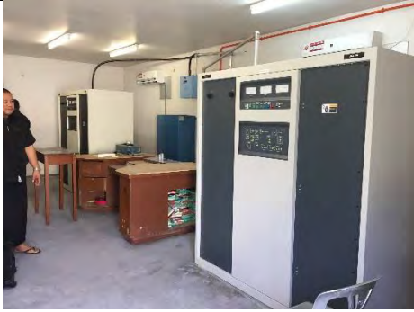
既存送信機(写真向かって左奥)と PREP プロジェクトで納入された送信機
