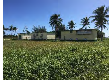
再塗装された送信機建屋外観
