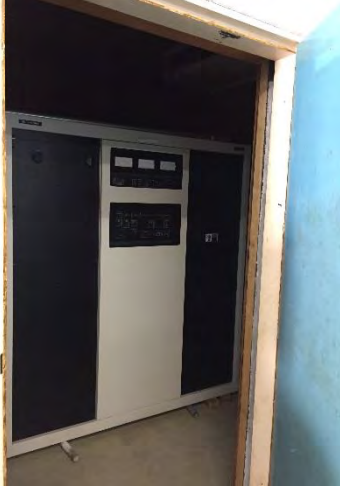
部品取用に保管されている旧中波送信機(故障、動作不可)
