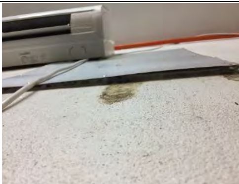
壁貫通孔周りの隙間
