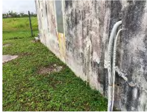
電線管被覆の損傷
