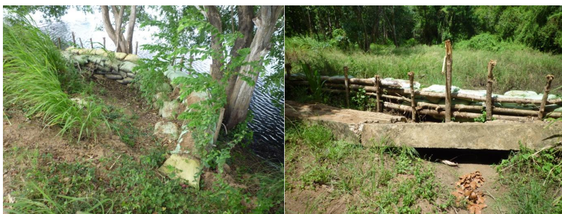
図 3.12.7 被害施設の応急復旧例(左：堤体パイピング、右：洪水吐損壊)
