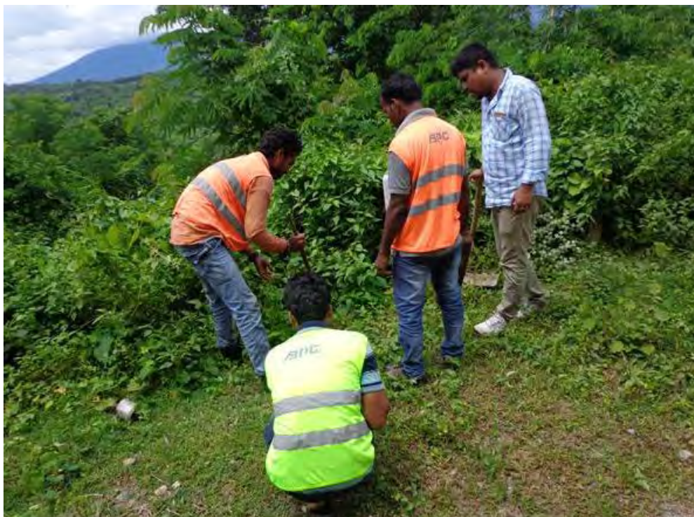
図 4.3-1 ボーリング調査 (木杭の設置)
