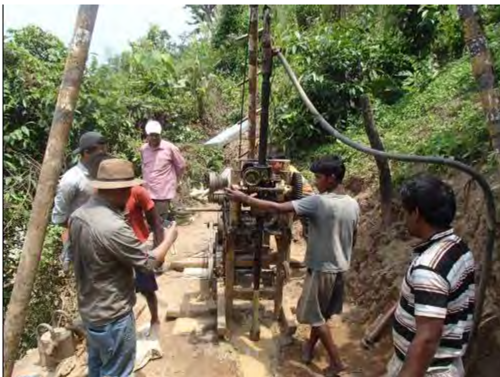
図 3.3-2 ボーリング調査 (掘進作業)
