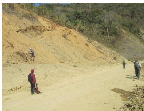
道路上での変状はない
