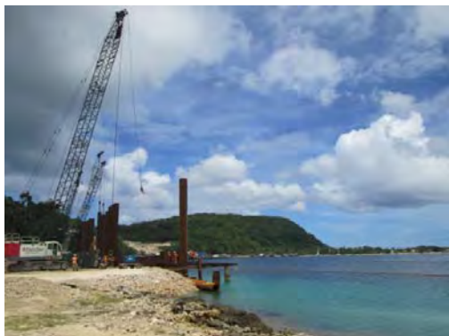
岸壁の鋼管矢板打設 1
