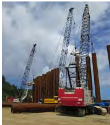
岸壁の鋼管矢板打設 2
