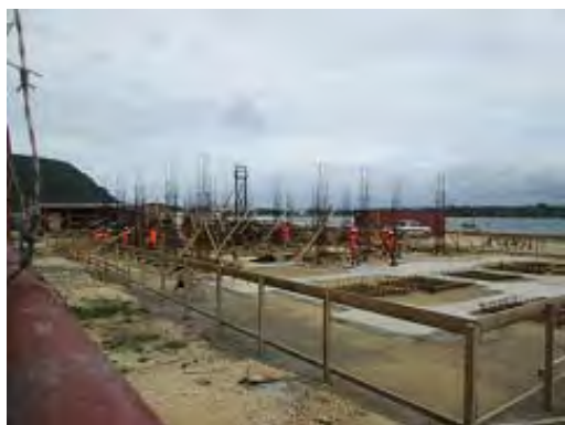
管理棟の基礎工
