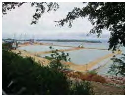
浚渫土砂仮置き場
