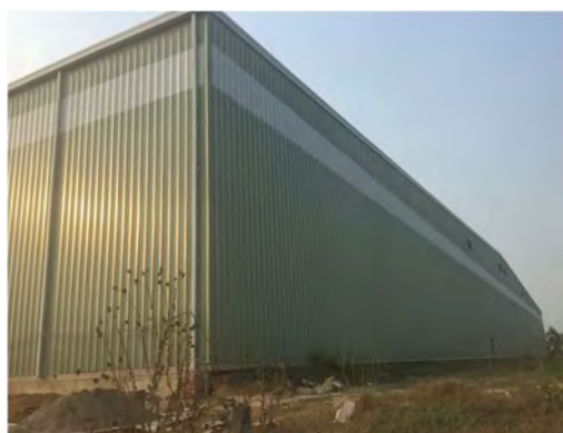
建設中の近代的冷蔵庫（外観）
