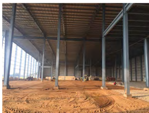
建設中の近代的冷蔵庫（内部）
