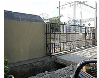
完成した中継基地ゲート
