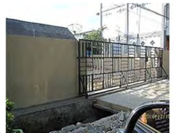
完成した中継基地ゲート
