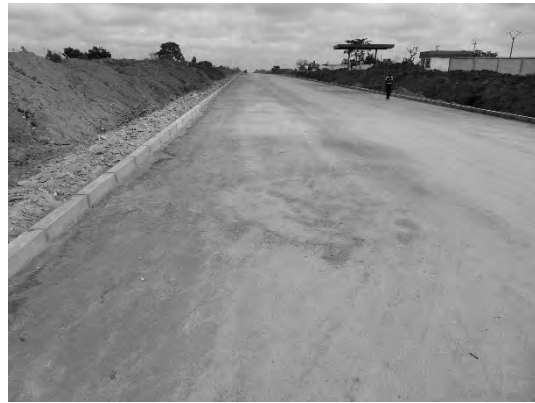
Achèvement d'une sous-couche stabilisée au ciment sur le tronçon Lomé-Tsévie au Togo
