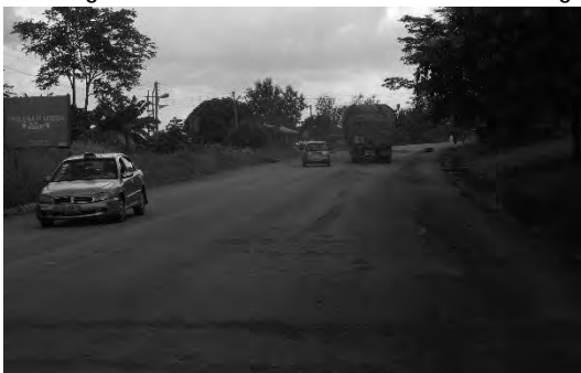
DBST sur le corridor ouest au Ghana
