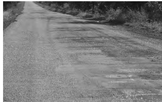
le DBST sur le corridor supérieur Est-Ouest
