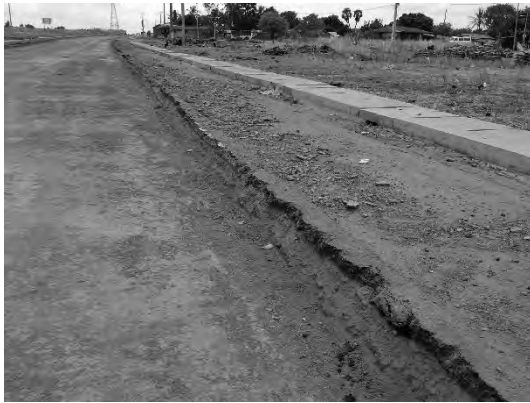
Après le retrait de la couche de base stabilisée au ciment sur la voie de contournement de Bafilo au Togo
