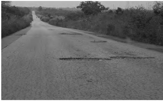
Tronçon Korhogo-Ferkessedougou en Côte d'Ivoire
