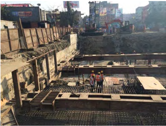
図 4.4.4 Howrah Maidan 駅土留壁と仮囲いの状況
