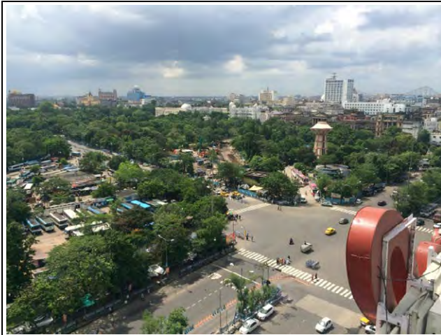
写真-7 Esplanade Station 計画地を南東方向より望む (撮影 2017/7/22)
