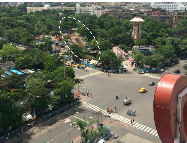
図 4.4.6 Esplanade 駅土留壁と仮囲（遠景）
