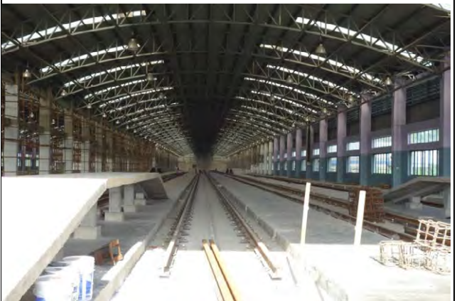
写真-12 Depot 内の検査庫の施工状況 (撮影 2017/ 6/27)
