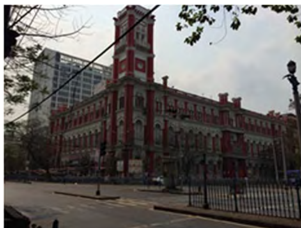
図 4.4.12 トンネル直上に位置する建物 S-1 (Indian post)
