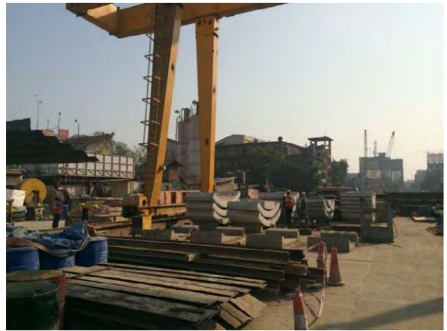
図 4.4.5 Howrah Maidan 駅ヤード内の資材置場
