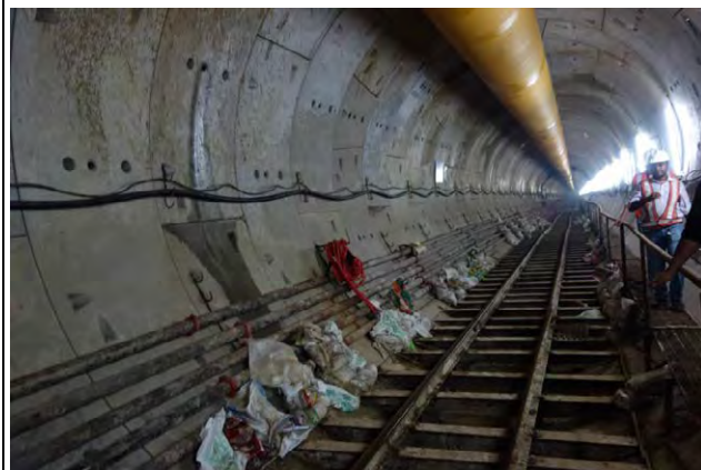
写真-11 Howrah ~ New Mahakaran Station 間のトンネル施工状況 (撮影 2017/ 6/27)
