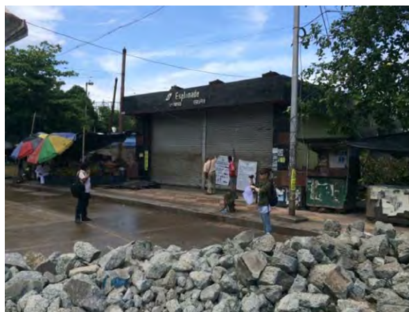
図 4.4.11 南北線 Esplanade 駅出入り口 NO.2 の封鎖状況
