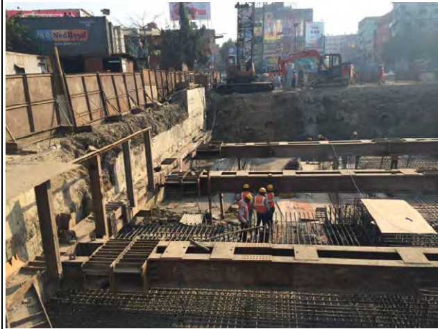
写真-9 Howrah Maidan Station 駅部開削工事状況 (撮影 2017/ 2/21)
