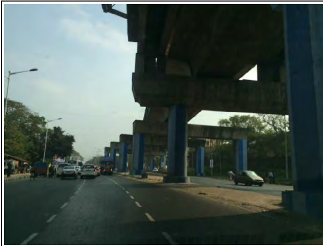
写真-13 高架区間の施工状況 (撮影 2017/ 2/26)
