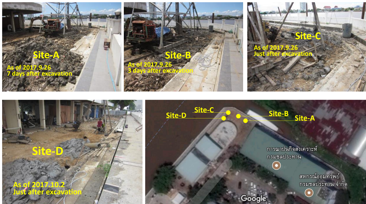
図 7.9.23 試料採取地点の状況（RID 敷地内の杭打ち工事現場）
