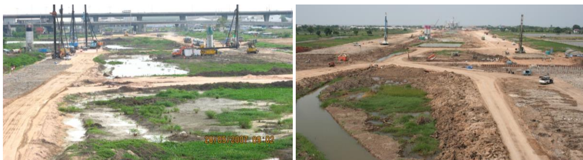
図 7.9.3 スワナプーム空港排水路施工時の工事用道路敷設状況
