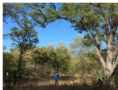
c. Estabelecimento da área a ser escavada
