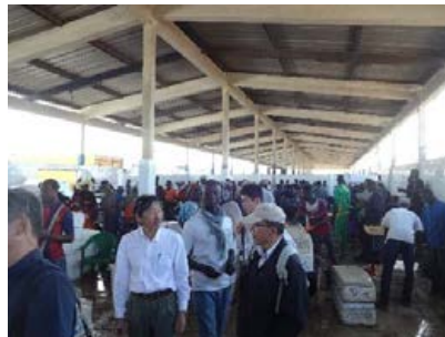
輸出区画（魚類）：開放型構造で塵埃や鳥獣・虫が施設内に侵入している。また、区画内は手狭で作業動線が錯綜している。
