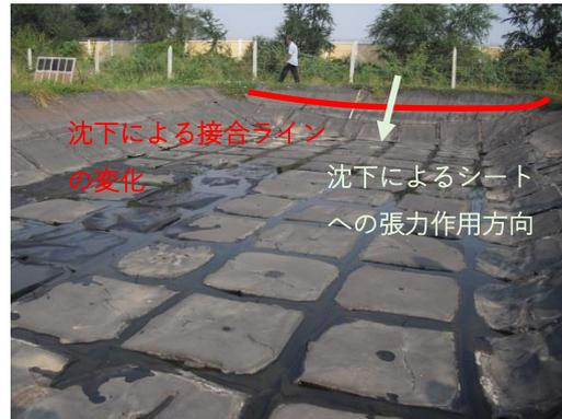
【写真】 地盤沈下（締め固め）によってシートに作用する張力
