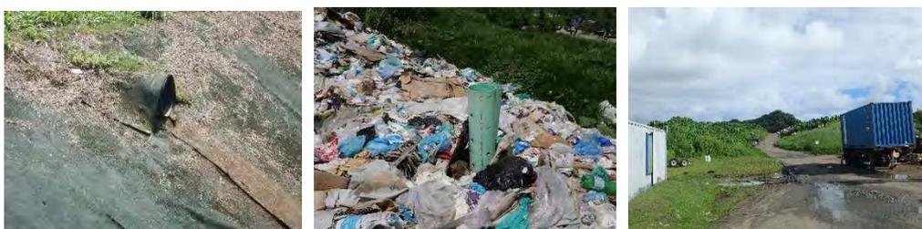
写真 2.2 浸出水集排水管出口(左)、ガス抜き管(中)、アクセス道路(右)の様子
