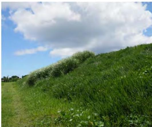
写真-8 堤堰を嵩上げし、処分場の延命化を図っている。
