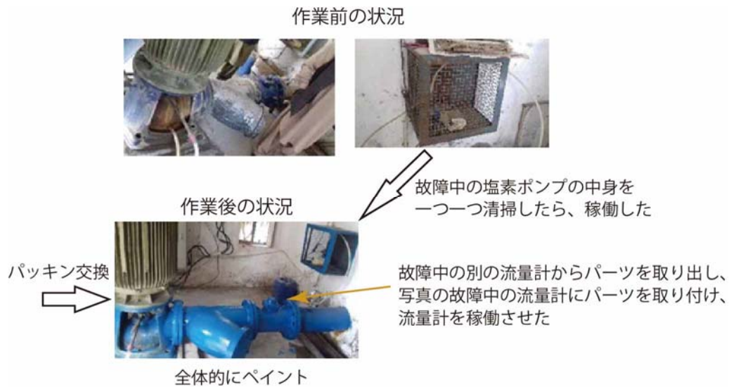
写真 3.4 塩素ポンプおよび流量計の修理
