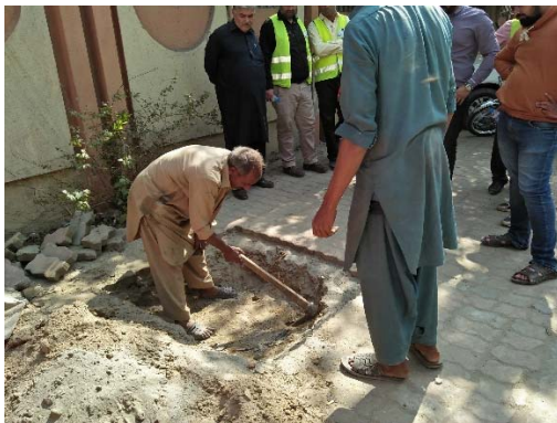
埋没したマンホール蓋
