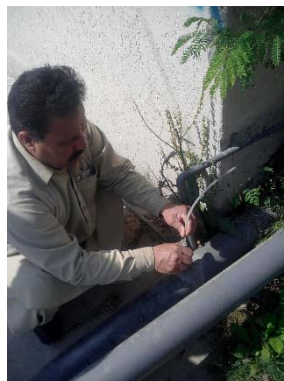
写真6.13 塩素注入設備のノズルに付着した滓の除去 (於：East Zone 60B Motimahalの井戸)
