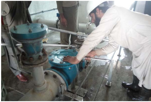
写真17: 逆止弁の開放
