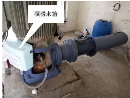
写真 3.27 安価な樹脂性の箱を潤滑水箱として設置
