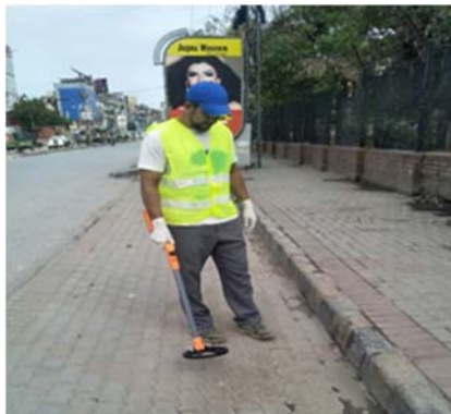
写真6.10 埋没したマンホール蓋の探知活動 （於：Commercial Market）
