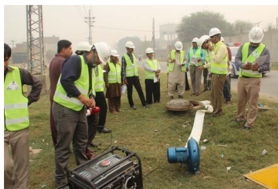
写真 3.7 マンホールの換気演習
