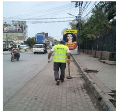
写真6.10 埋没したマンホール蓋の探知活動 （於：Commercial Market）
