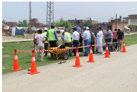
写真12: 現場演習における安全対策
