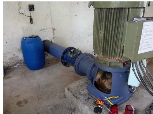
写真 3.31 塗装による防食
