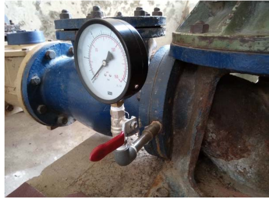
写真 3.21 ポンプ性能および運転状況の確認の重要性に関する説明後、設置した圧力計
