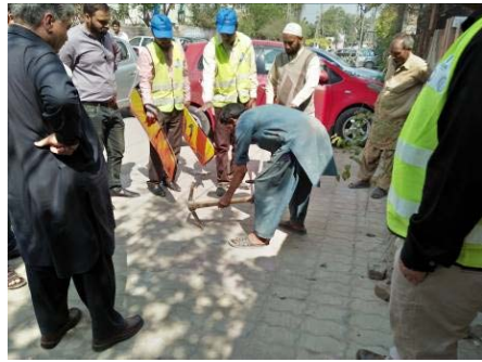
探知された場所の掘削
