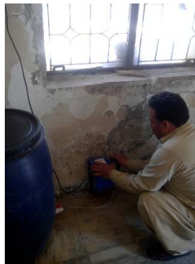
写真6.12 井戸の塩素注入量の調整 (於：East Zone 60B Motimahal)
