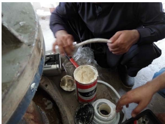
写真 3.24 写真 3.23 の作業状況
