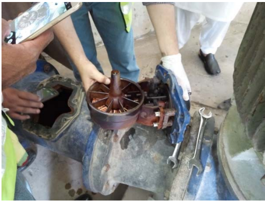
写真 3.28 既存の機械式流量計の内部確認
