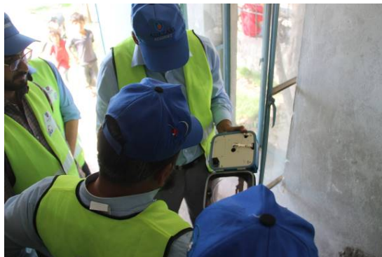
写真 3.5 井戸ポンプからの配水圧の測定支援
