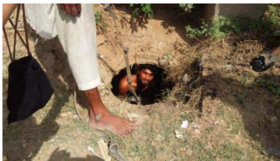
写真2.1 人力によるマンホール内清掃 (Gujranwala WASA)
