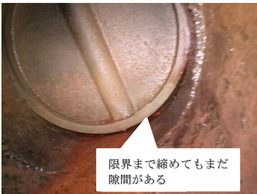
写真 3.16 錆の影響により仕切弁の全閉不可
