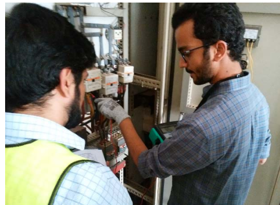
写真3.13 絶縁計やテスターを用いた各 부품の性能検査
