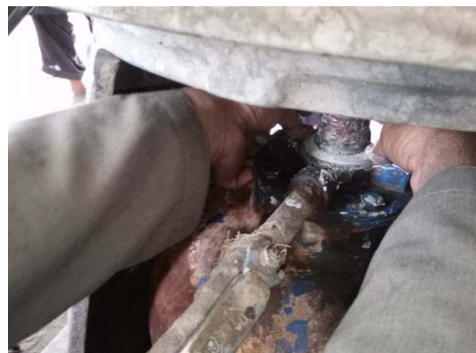
写真 3.25 写真 3.23 の作業状況
