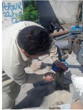
グラウンドパッキンの交換中
