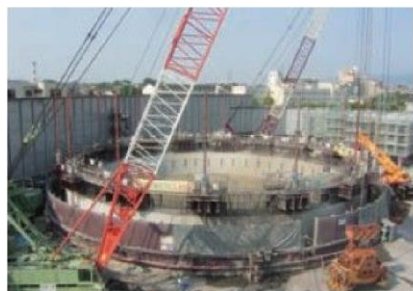
【淀川水系 寺畑前川調節池整備工事 (第1工区)】
