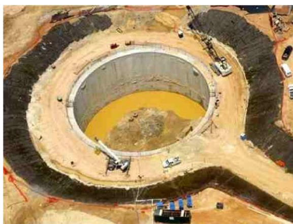
図 7.5.10 RC 連続地中壁円形立坑施工例図
