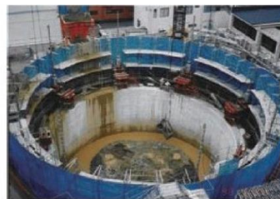
【京都桂貯留池整備工事】
