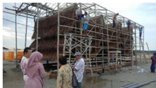
流下式装置の建設風景(その2)
