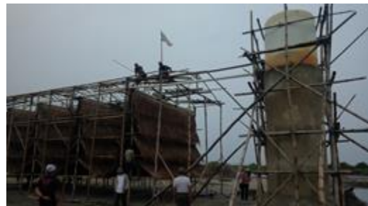
流下式装置の建設風景(その1)
