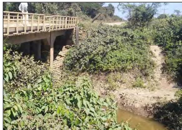
Estado de erosión de las protecciones existentes
