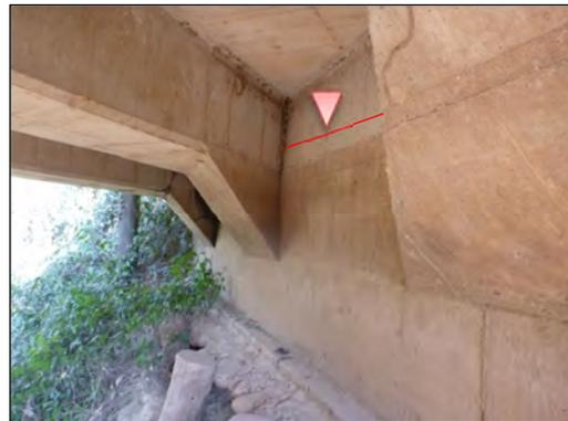
Marcas del nivel máximo del agua (estribo A2)
