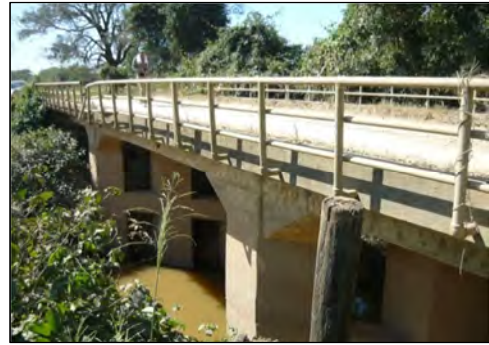
図 3-2-16 既存橋梁側面
