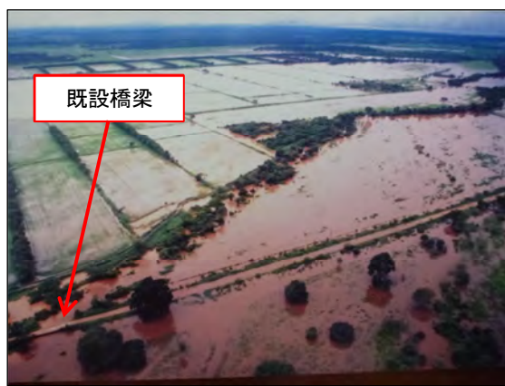
1998 年の既存橋梁周辺の氾濫状況
