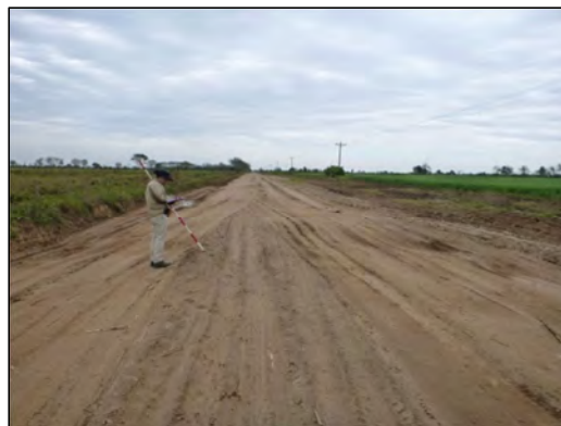
図 2-1-5 砕石が転圧され比較的良好な状態の路面 図 2-1-6 細砂やシルトが路面に分布し状態が悪い
