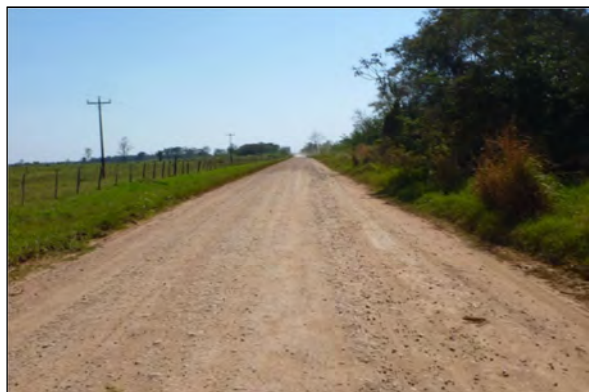
図 2-1-5 砕石が転圧され比較的良好な状態の路面 図 2-1-6 細砂やシルトが路面に分布し状態が悪い
