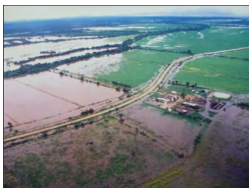
写真の右側が冠水 (Sta.8+000)
