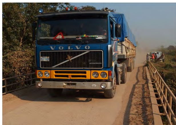
橋梁を走行する過積載車両
