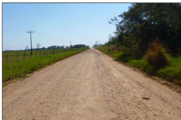
図 2-1-5 砕石が転圧され比較的良い状態の路面 図 2-1-6 細砂やシルトが路面に分布し状態が悪い
