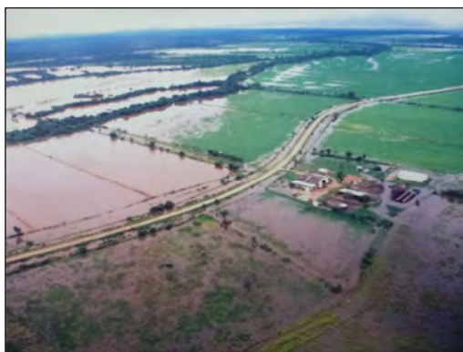
写真の右側が冠水 (Sta.8+000)
