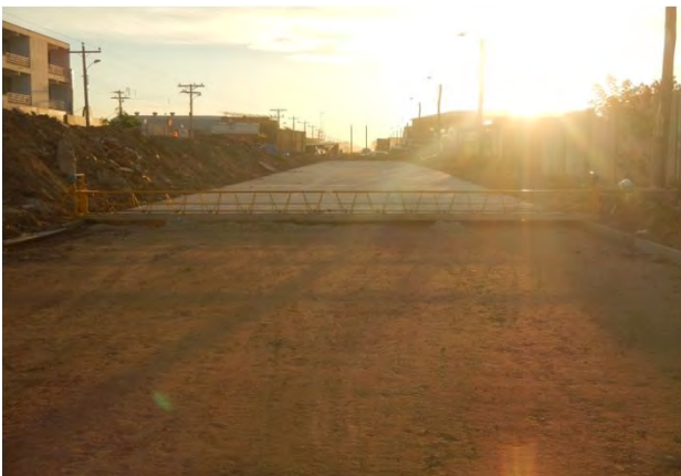
接続道路の整備
