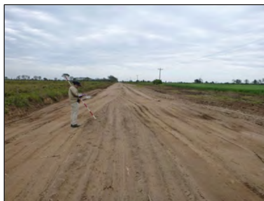
図 2-1-5 砕石が転圧され比較的良い状態の路面 図 2-1-6 細砂やシルトが路面に分布し状態が悪い
