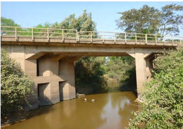
パイロン川に架かる橋梁
