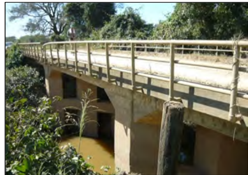
図 3-2-16 既存橋梁側面
