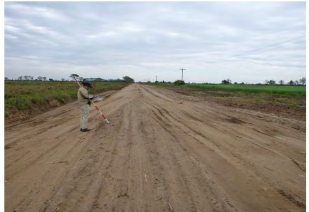
細砂やシルトが路面に分布し状態が悪い
