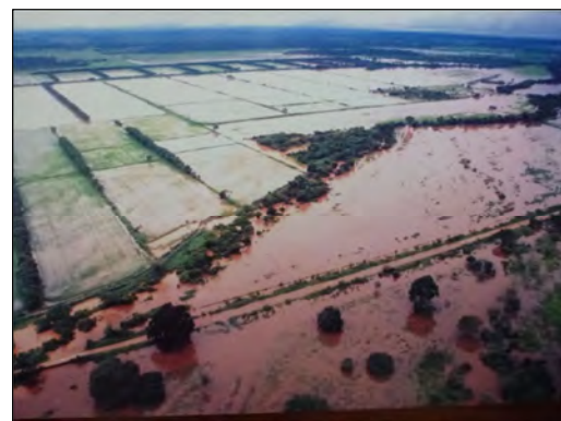
パイロン川の下流で道路が冠水 (Sta.9+500)
