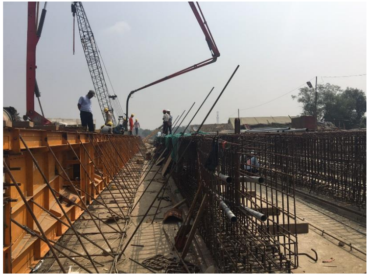
写真 20 Nga Moe Yeik 橋の工事現場5
