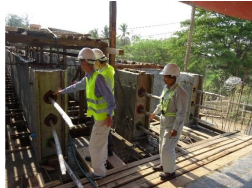
写真 12 Taung Bway 橋の工事現場4
