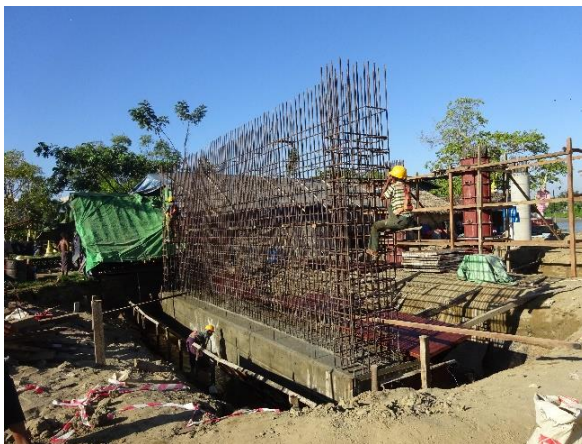
写真 17 Nga Moe Yeik 橋の工事現場2
