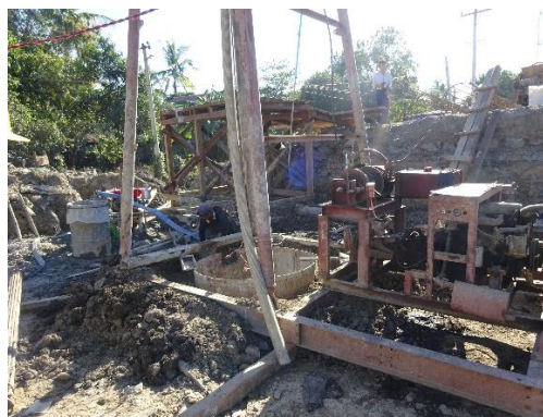
写真 10 Taung Bway 橋の工事現場2
