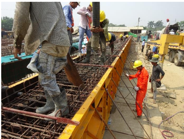
写真 21 Nga Moe Yeik 橋の工事現場6
