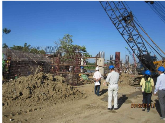
写真 16 Nga Moe Yeik 橋の工事現場1
