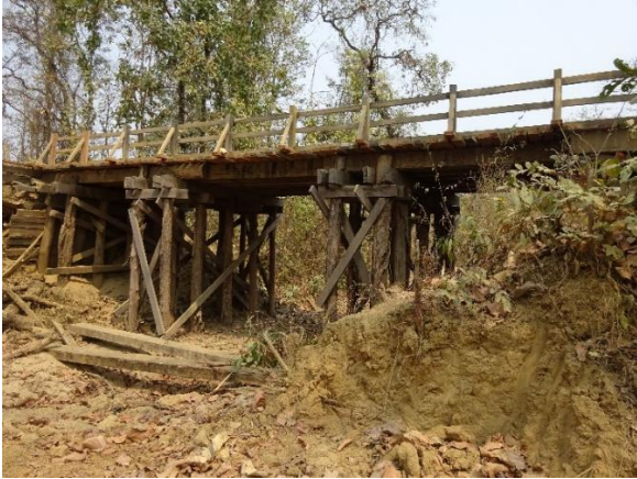
地方幹線道路橋の状況(ザガイン地域)
