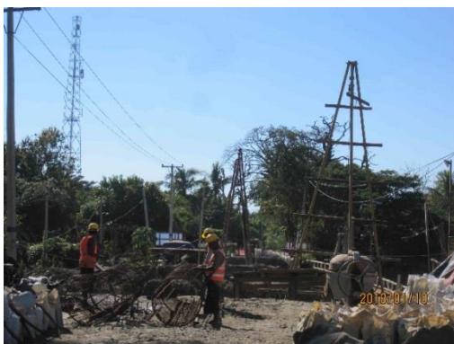
写真 9 Taung Bway 橋の工事現場1
