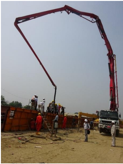
写真 19 Nga Moe Yeik 橋の工事現場4
