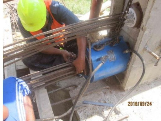
写真 14 Taung Bway 橋の工事現場6
