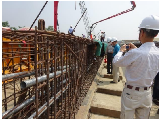
Nga Moe Yeik 橋の工事現場
