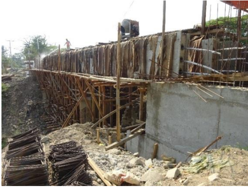
写真 13 Taung Bway 橋の工事現場5
