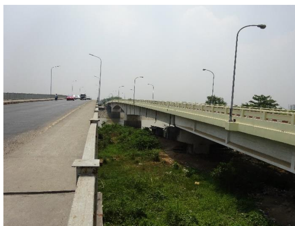
写真 4 新旧ツワナ橋(左:旧 PC 橋 右:新鋼橋)
