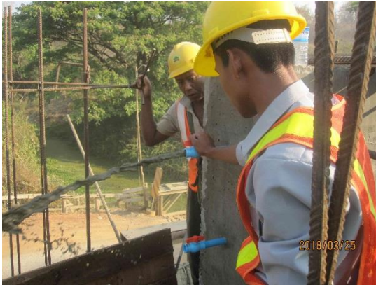
写真 15 Taung Bway 橋の工事現場7
