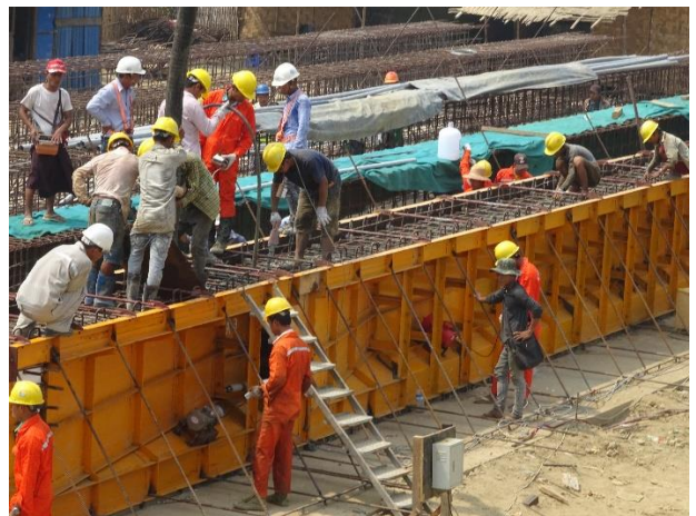
写真 22 Nga Moe Yeik 橋の工事現場7
