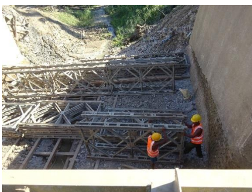
写真 11 Taung Bway 橋の工事現場3
