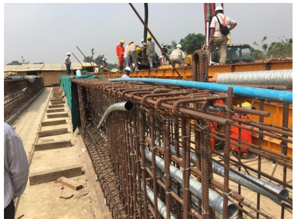
写真 18 Nga Moe Yeik 橋の工事現場3
