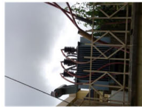
FIG. 3 – 500KVA TRANSFORMER
