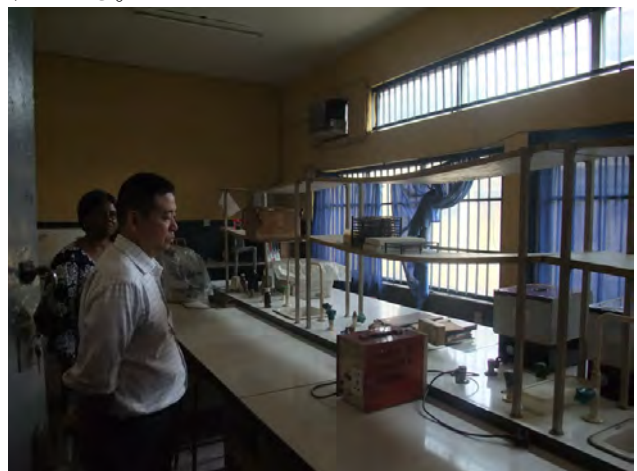
写真 1 6 CPHL 細菌学検査室内部。機械換気設備はなく窓開口による自然換気のみ。前室、手洗い器の設置もない。
