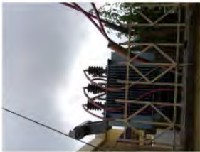
FIG. 3 - 500KVA TRANSFORMER
