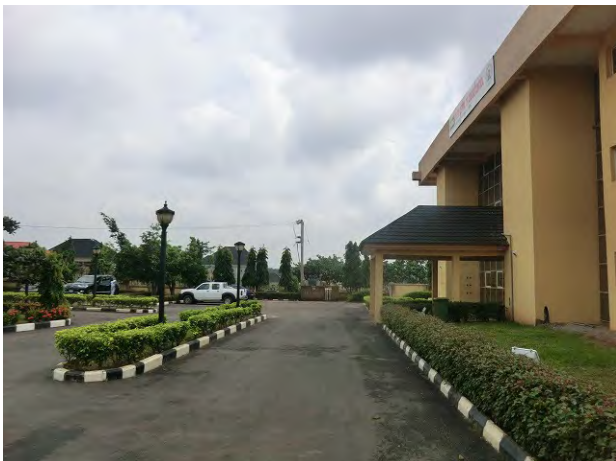
写真5 NRL 既存棟エントランス。既存検査室との動線連携のため、計画施設を同エントランス部分で接続する計画とする。
