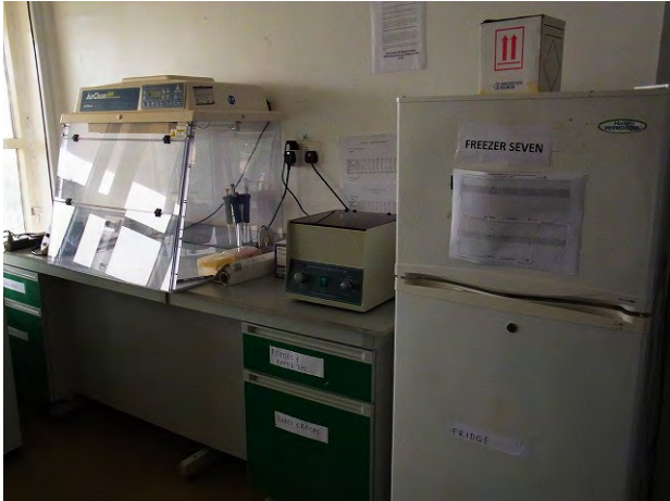
写真7 NRL 既存棟 PCR 室。PCR ワークステーション、冷蔵庫。全館検査室は比較的広く、利用スペースには余裕がある。他方、換気、差圧・気流管理、手洗器装備は不十分であり、感染防止、事故等緊急時の対策への配慮が不足している。
