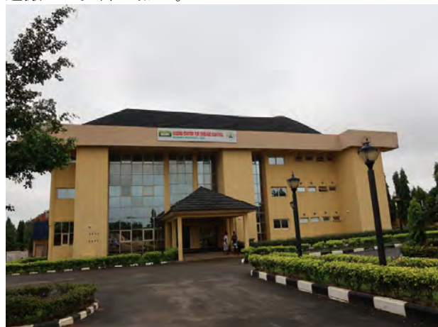
写真4 NRL 既存棟。保健省施設を改築し 2011 年から稼働。2016 年より USCDC の支援を受け P2 検査室が設置されている。
