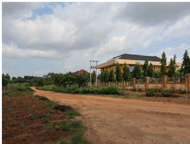
写真2 前面道路。市内幹線道路から分岐し建設用地まで延長約 1.5km の土道である。路面状況は悪く、雨期には普通乗用車の通行が難しくなる。資機材の運搬には支障は無い。
