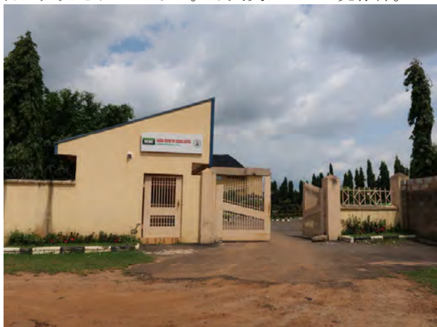
写真3 既存ゲート。警備員による入退場管理が行われている。工事中は工事用搬出入路に使用するため、NRL 既存棟へのアクセスを別途に仮設する。
