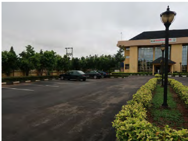
写真1 本件建設用地。ガドウワ地区 NRL 内駐車場の一角でありアスファルト舗装がされている。既存照明灯、植栽・樹木の撤去移設を要する。地中障害物は発見されていない。写真奥は NRL 既存棟。
