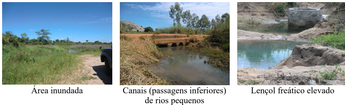
Figura 8.3 Área inundada e instalações de drenagem existentes em Nampula
