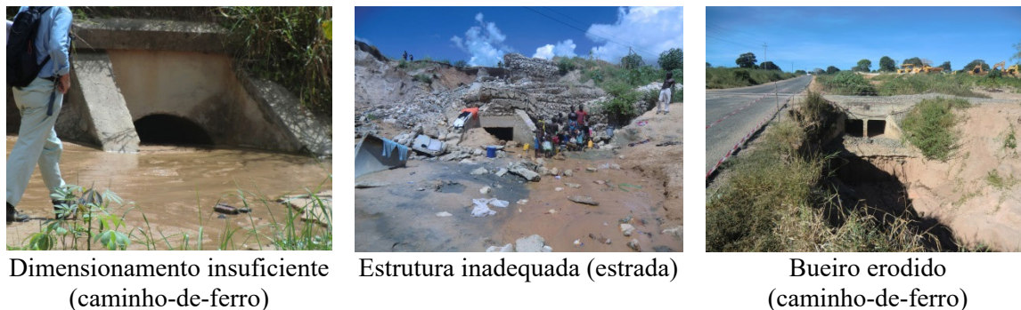
Figura 8.2 Estruturas de drenagem existentes em Nacala
