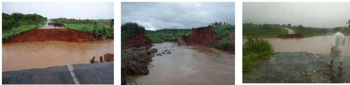
図 8.1.3 豪雨による道路及び橋梁の流失（2015年1月）
