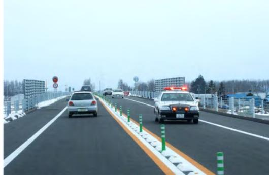
図 8.6.2 我が国の車線分離標の例（2 車線暫定供用時には適用しない）
