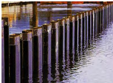
鋼製鉛直遮水壁
