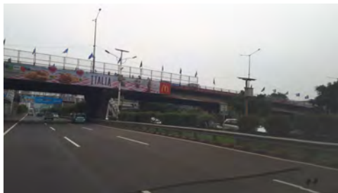
Angrek Neli Murni Flyover
