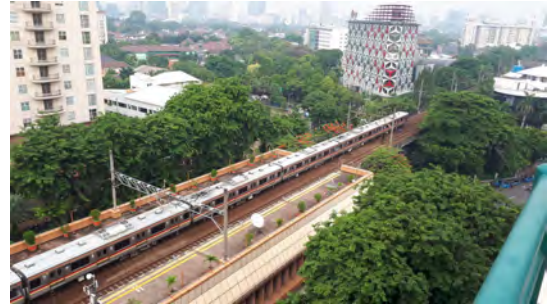
Manggarai-Gambir-Jakarta Kota Elevated Track
