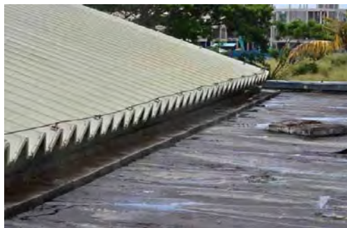
写真 15 アスファルト防水(1)
