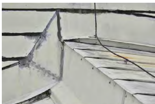
写真 17 屋根補修箇所(1)
