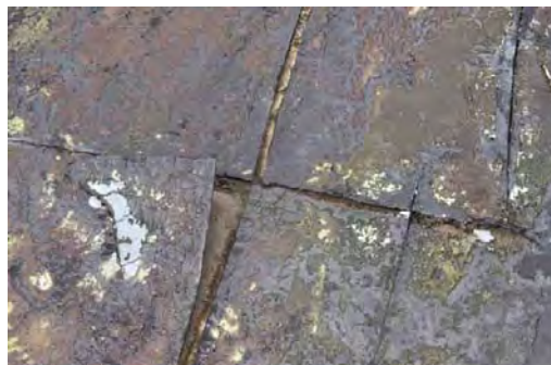
写真 16 アスファルト防水(2)
