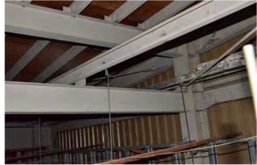
写真 24 天井裏の構造体の状態(2)
