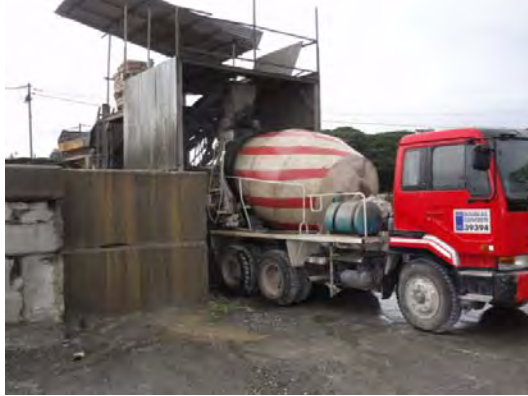
写真 66 Douglas Concrete のコンクリートプラント
