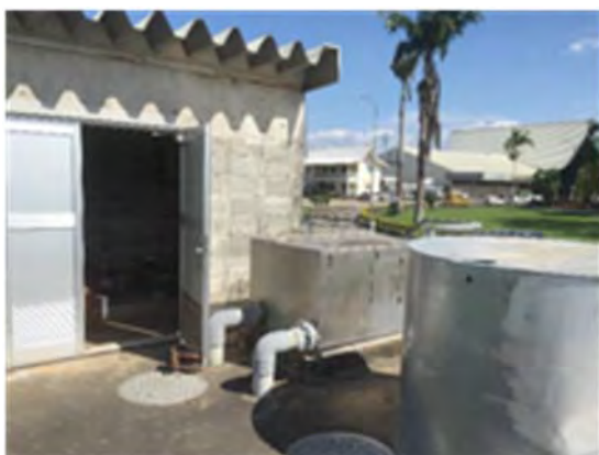
写真 39 スクリーン及び機械室入口
