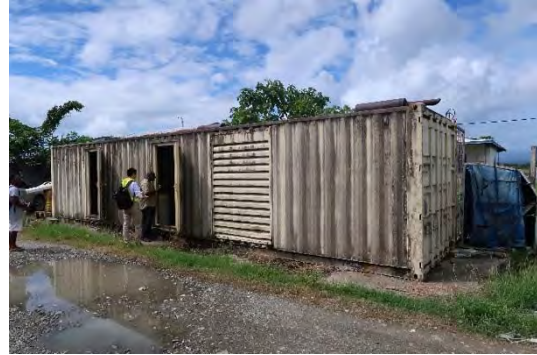
写真 62 発電機収容コンテナ
