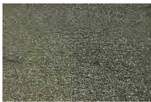
写真3 国際線エプロンの アリゲータークラック (ユニット5)
