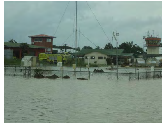
写真12 洪水により観測不能になった ホニアラ空港の気象観測設備 2014年4月の洪水時に撮影
