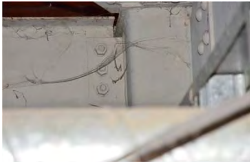
写真 23 天井裏の構造体の状態(1)
