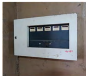
写真 48 火災表示盤
