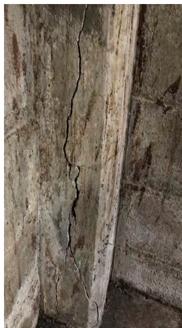
写真51 管制塔のコンクリート柱の亀裂(1) 写真52 管制塔のコンクリート柱の亀裂(2)
