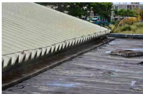
写真 15 アスファルト防水(1)
