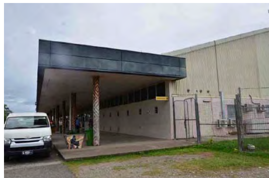
写真 14 国際線旅客ビル外部仕上げ
