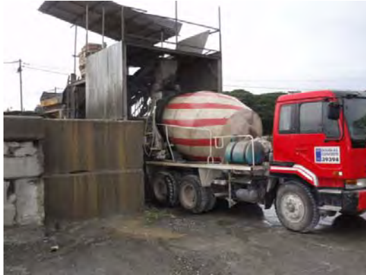
写真 66 Douglas Concrete のコンクリートプラント
