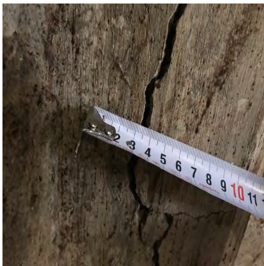
写真51 管制塔のコンクリート柱の亀裂(1) 写真52 管制塔のコンクリート柱の亀裂(2)
