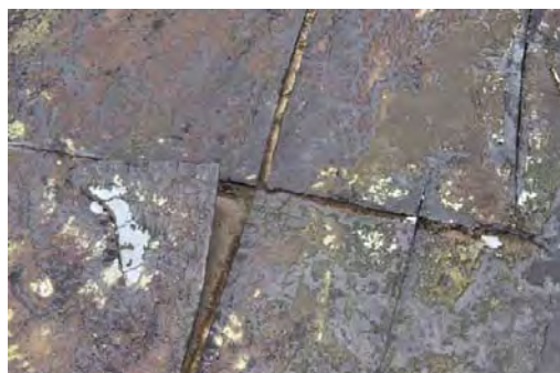
写真 16 アスファルト防水(2)
