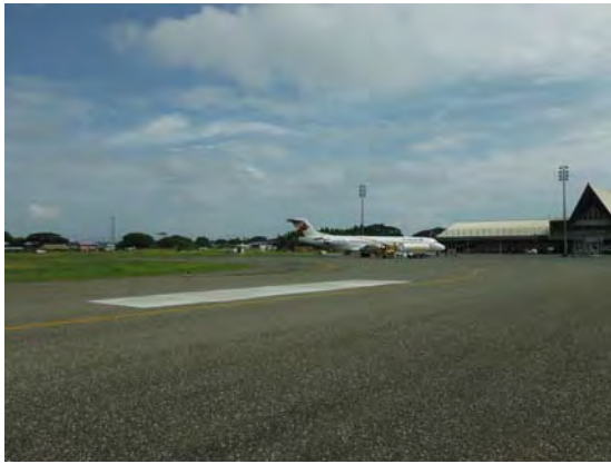
写真9 国際線エプロン 誘導路から望む
