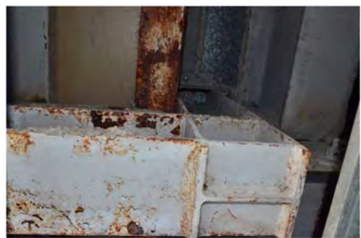
写真 27 エアサイドの天井裏
