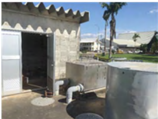
写真 39 スクリーン及び機械室入口
