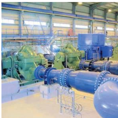
Насосная станция передачи на дальнейе расстояние Мирфа
