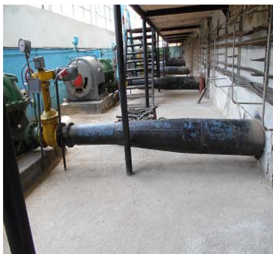
図 3-5 Soilik 1 ポンプ場の取換えた既設バルブ・吐出配管
