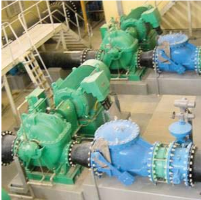
Оросительная насосная станция TSE-2
