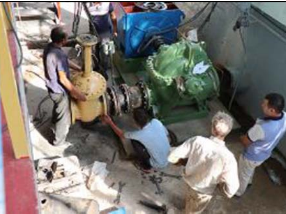
据付工事の様子
