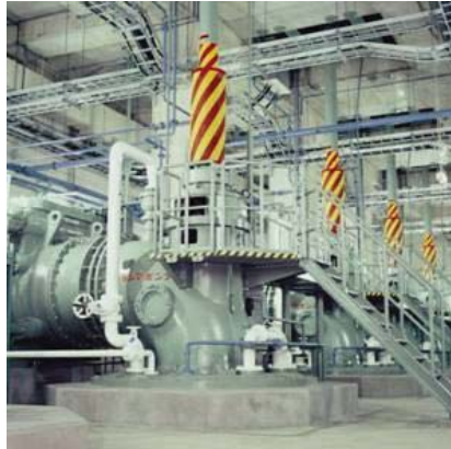
Насосная станция дренажа сточных вод
