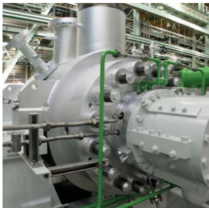
Бочкообразный питательный насос котла Сверхкритическая ТЭС Чабра Индия, 2 × 660МВт
