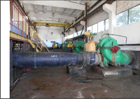
北タシケントポンプ場の旧型ポンプ
