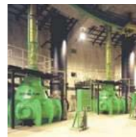
Вертикальный осецентробежный со спиральным кожухом канализационный насос в Гонконге
