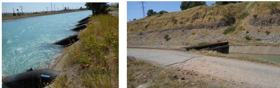
図 3-4 Soilik 1 ポンプ場の取水配管および吐出本管
