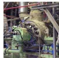
Питательный насос котлоагрегата для ГЭС в Саудовской Аравии
