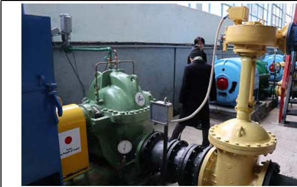
本事業で導入したポンプ
