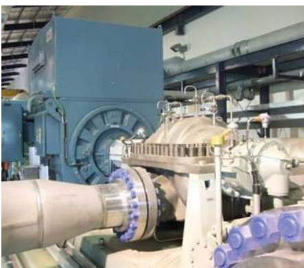
Питательный насос высокого давления Опреснение Золотой Берег (ОО) Австралия
