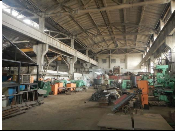
民間ポンプ製造サービス工場
