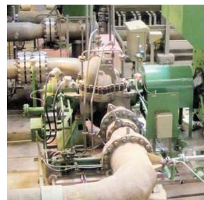
Питательный насос высокого давления Опреснение Шуайба III (ОО) Саудовская Аравия
