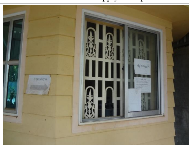
民営水道②料金支払い所
