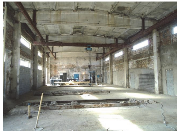
改修中のElita農場の建物 (種子調整機設置予定)
