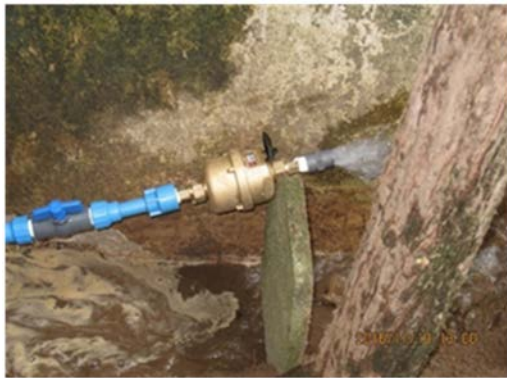
配管後の排水作業（於：Dehiwala 給水区）
