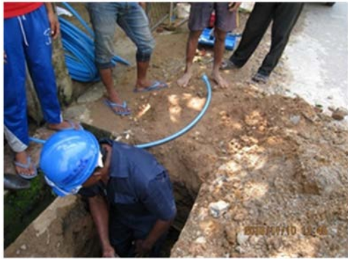
無収水削減対策に係る工事現場。塩ビ管を PE 管に布設替え（於：Dehiwala 給水区）
