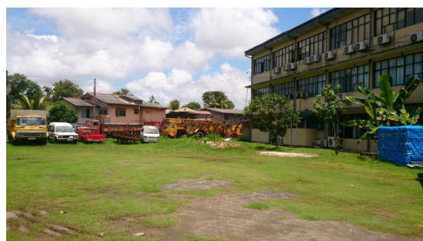
トレーニングヤード建設予定地（於：研修センター、MWSDB テラワラ事務所）
