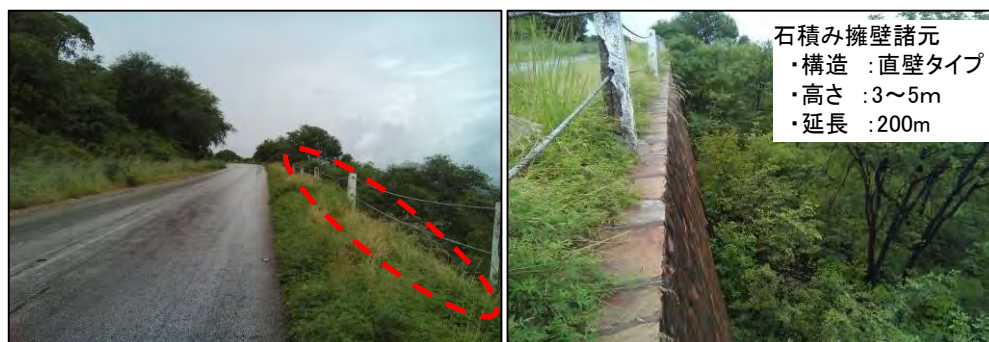
写真 9 既存擁壁区間周辺状況
