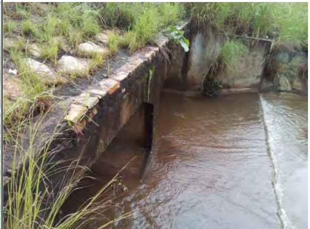
既存施設 ボックスカルバート
