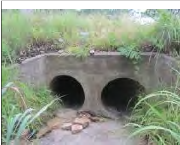
既存施設 パイプカルバート
