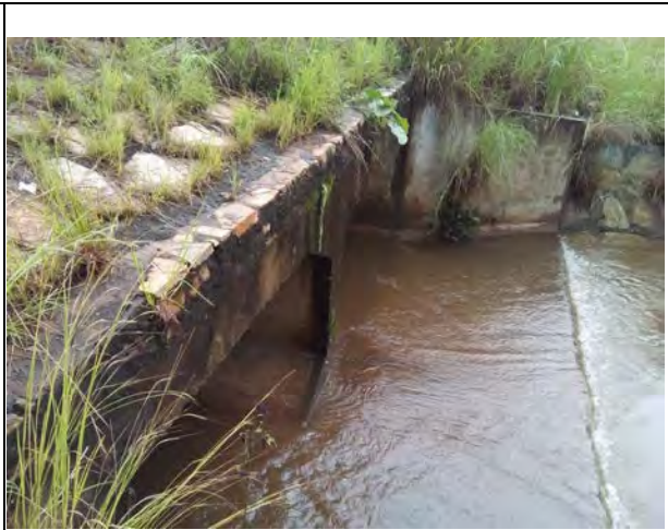
既存施設 ボックスカルバート
