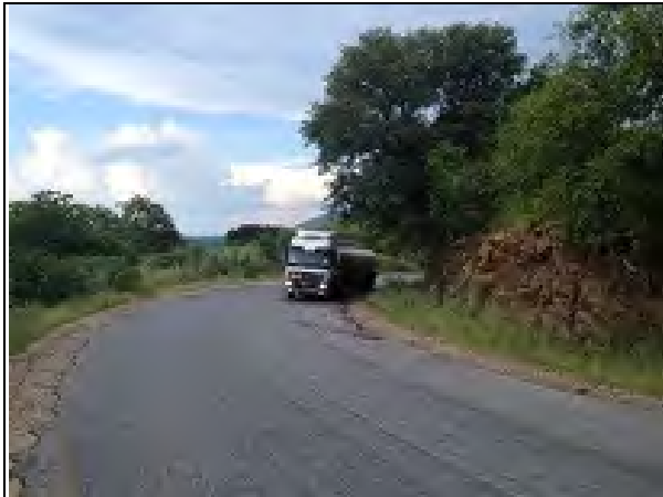
対象道路の現状 見通しの悪いカーブが連続
