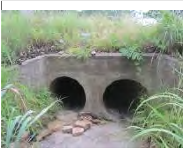
既存施設 パイプカルバート
